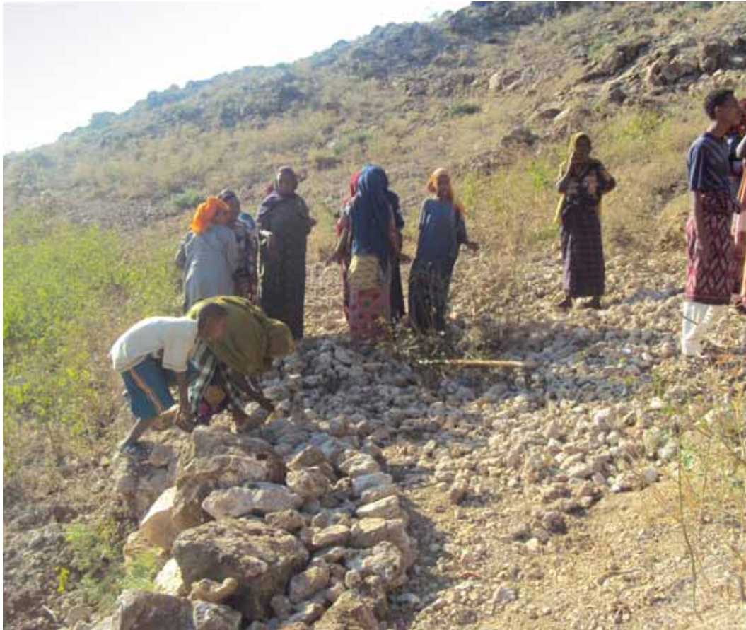
Creating a stone bund in Ander Kello
